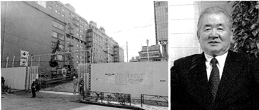
左：基礎工事が進む新ビル「東京スタイル青山計画」は当初発表とは異なり1～2階に他社テナントを入れる 右：TSIの三宅正彦・会長兼社長
